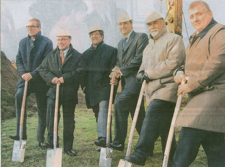
Großer Auftritt beim ersten Spatenstich: von links Michael Schäfer (Beratungsfirma Freshfields Bruckhaus Deringer), Bürgermeister Frank Ruppert, Thomas Weber (Oberbauleiter bei Müller-Altwater), Markus Koch (Prokurist und Leiter Investorenprojekte bei Müller-Altwater), Bürgervorsteher Eckhard Gerber und Staatssekretär Klaus Schlie. Fotos: MARC VON KOPYLOW
